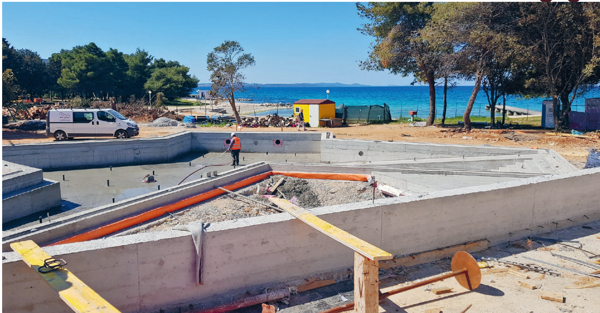
Obras del Falkensteiner Premium Camping Zadar (Croacia).
