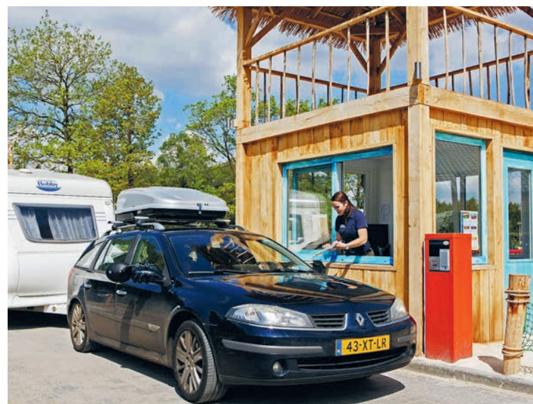
Puesto de entrada Vakantiepark Stoetenslagh (Países Bajos)
