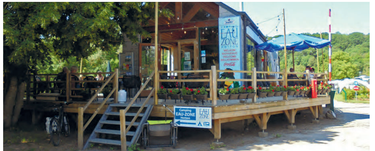
Certains bâtiments du Camping Eau-Zone ont été surélevés. Ces aménagements semblent avoir servi dans la nuit du 14 au 15 juillet 2021.
