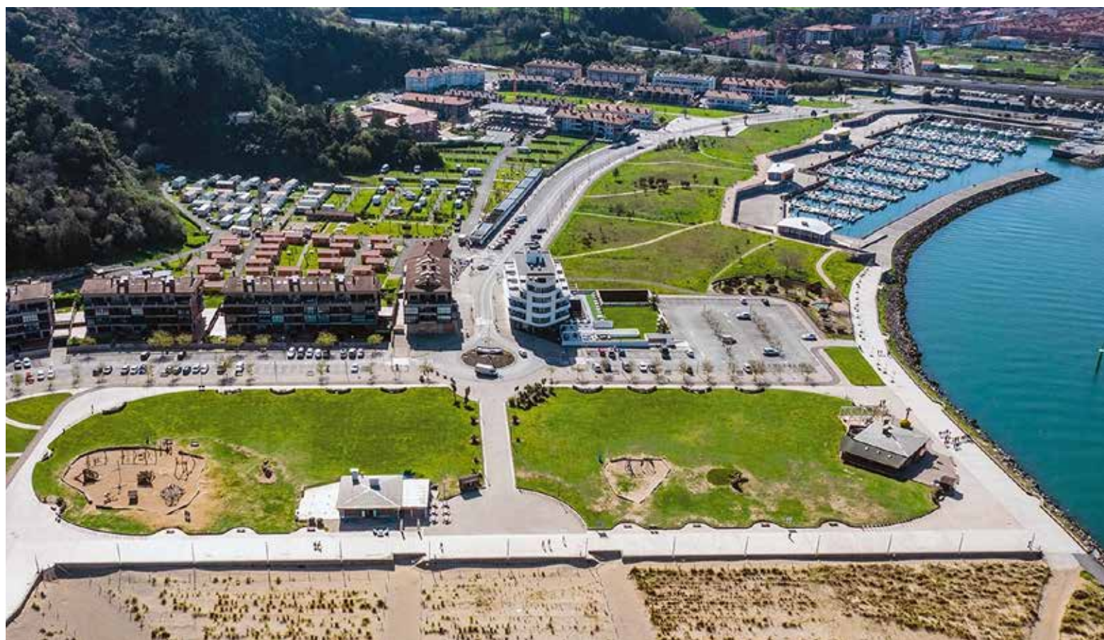
Om water te besparen wordt op Camping Orio binnenkort het zwembad aangepast. Van chloor naar zout water en van 1,80 meter diepte naar 1,40 meter.
