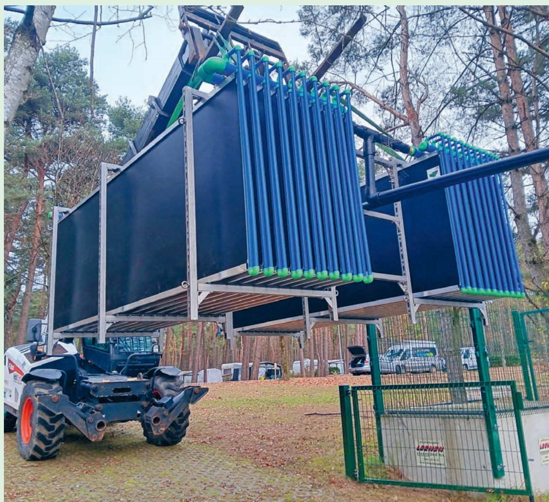
En diciembre de 2025 se instaló el intercambiador de calor en el lago de baño del Camping De Lilse Bergen.
