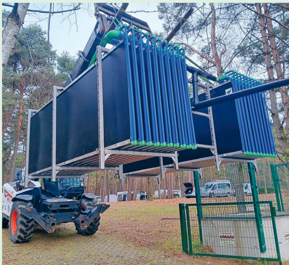
In december 2025 werd de warmtewisselaar geplaatst in de zwemvijver van Camping De Lilse Bergen.
